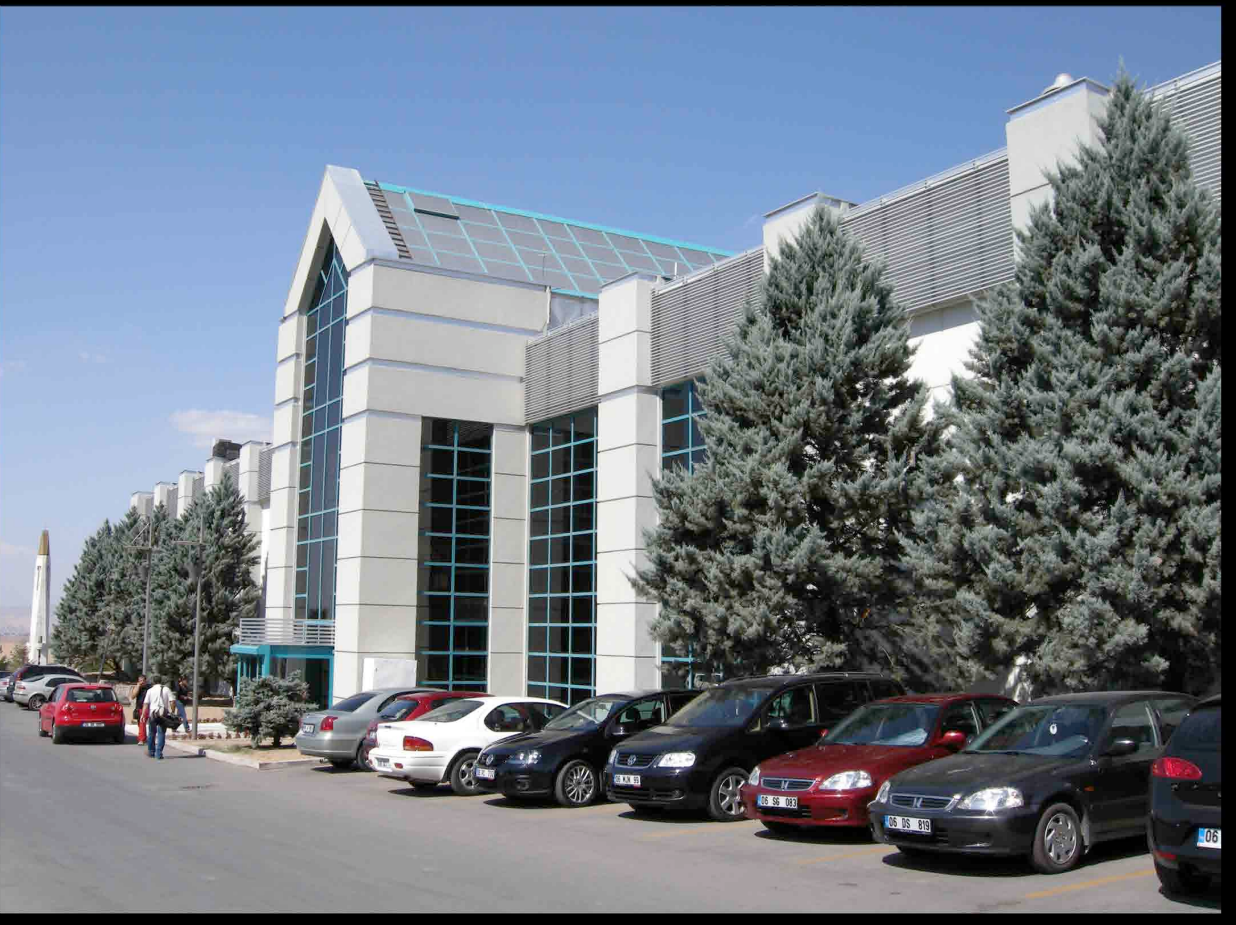
SPORTS INTERNATIONAL Ek Havuz ve Renovasyon Projesi Spor Merkezi 2008 Bilkent, ANKARA
